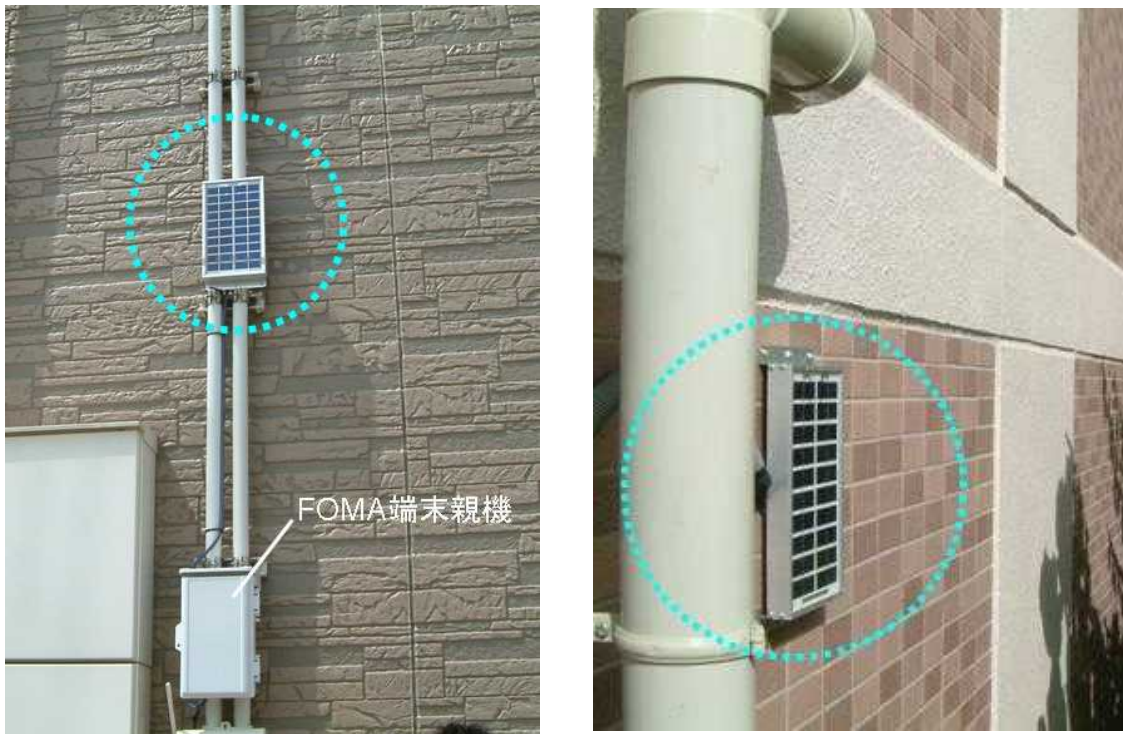
図2 ソーラーパネルの垂直設置例
